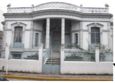
CHALET DE GUILLERMO LANDA Construida en el siglo XIX.
