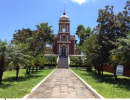
TEMPLO DEL TEPEYAC Edificada a finales el siglo XIX con recursos propios de la señorita Clotilde Alvarez por una promesa a cumplir a la Virgen de Guadalupe.
